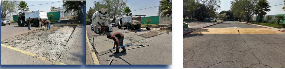
Ilustración 15. Elaboración de paso peatonal.
