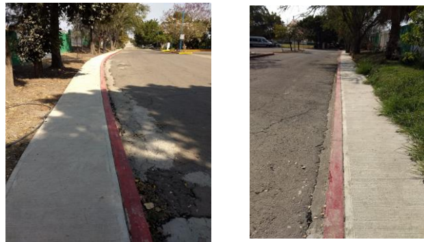
Ilustración 13. Mantenimiento a la banqueta de acceso principal.
