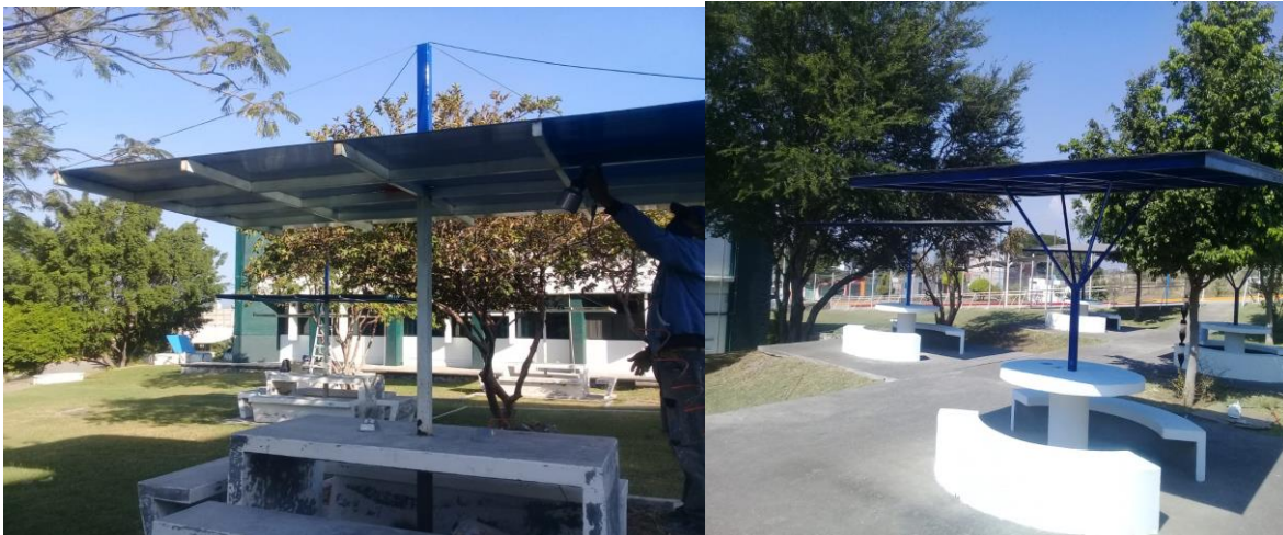
Ilustración 22. Trabajos de pintura de imagen institucional.
