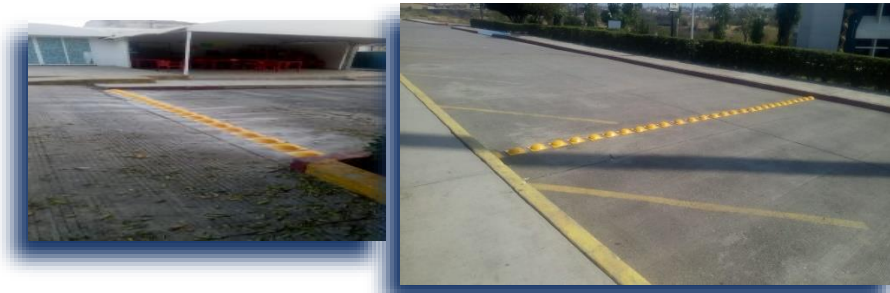
Ilustración 16. Colocación de boyas metálicas.
