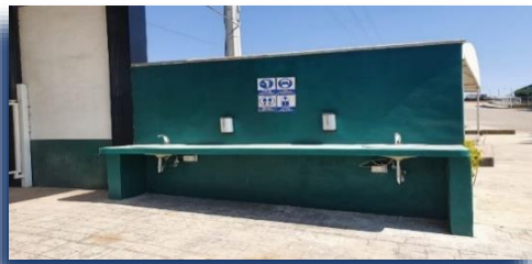
Ilustración 41. Colocación de lavabos.
