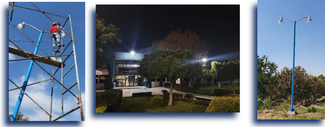
Ilustración 38. Instalación de luminarias en barda perimetral.
