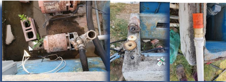
Ilustración 32. Mantenimiento preventivo y correctivo a bombas.
