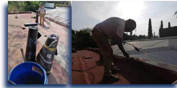
Ilustración 24. Impermeabilización de cafetería 1.
