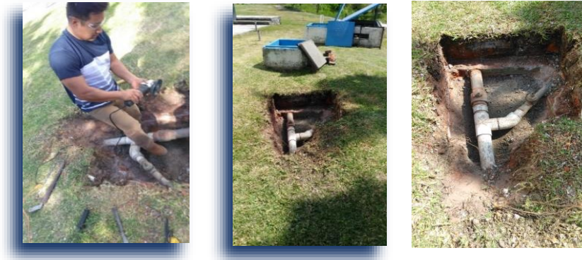
Ilustración 33. Reparación de dos válvulas de paso.
