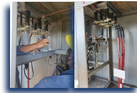
Ilustración 36. Mantenimiento preventivo a subestación eléctrica.
