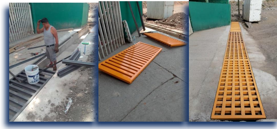
Ilustración 29. Mantenimiento a desagua pluvial.
