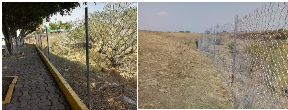
Ilustración 18. Colocación de maya ciclónica.
