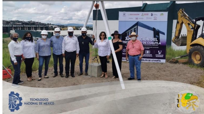
Ilustración 47. Colocación de la primera piedra
