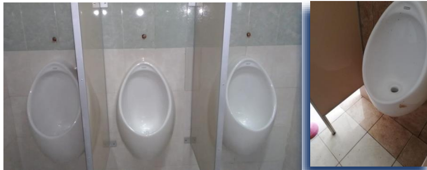
Ilustración 34. Colocación de mingitorios secos.
